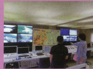
ダム管理所操作室 実際の放流操作装置や監視カメラを点検しました。
