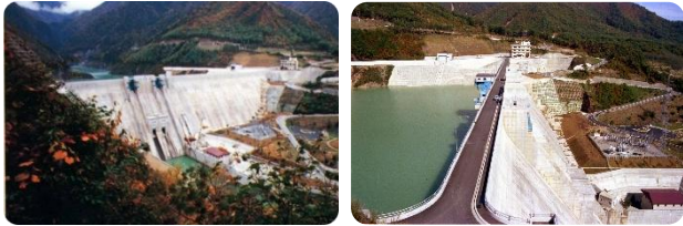
大町ダム建設当時の写真
