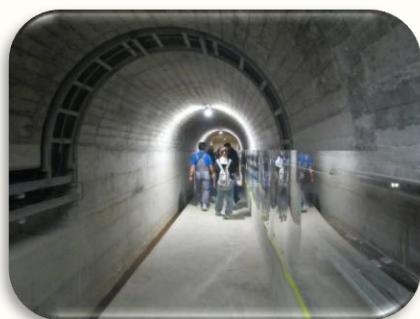
ダム内部見学
