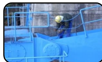
機械設備の点検
