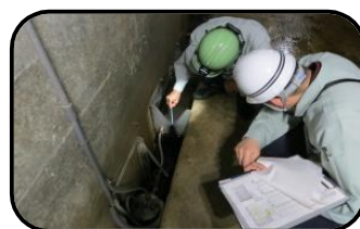
堤体の漏水点検
