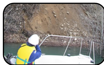
ダム湖内の巡視点検
