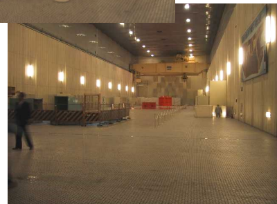
新高瀬川発電所
