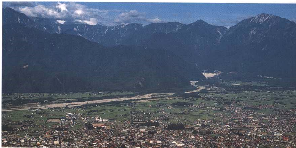
大町市内から眺める大町ダム、高瀬川の流れの景観
