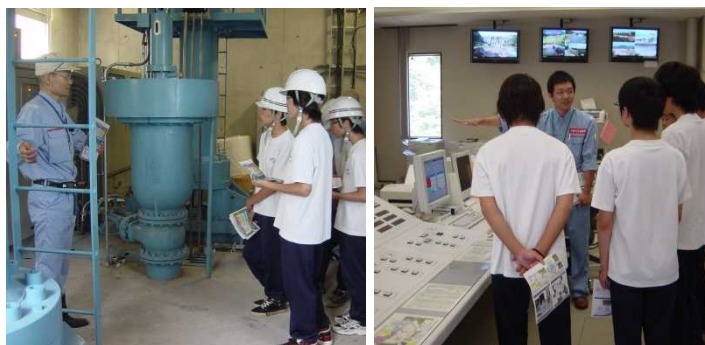
水を放流するゲート、ダムの司令塔ダムコンを点検。
