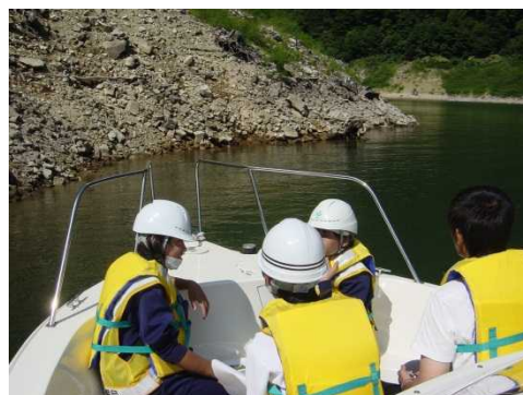
巡視船に乗って、ダム湖の斜面を点検しました。
