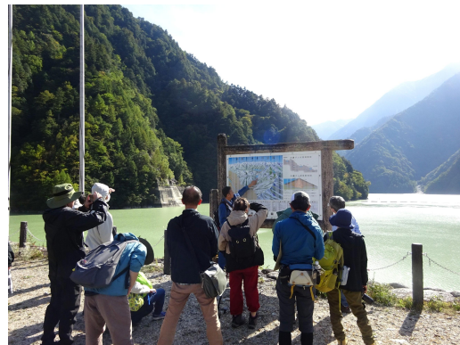
高瀬ダム（天端での説明の様子）
