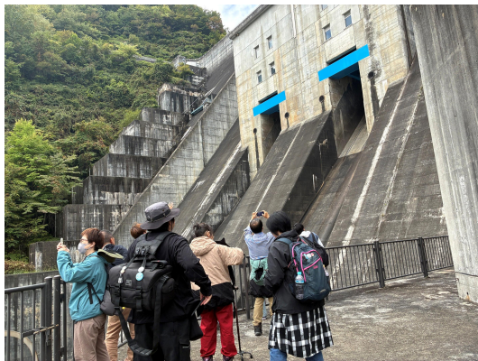
大町ダム（ゲート放流口付近）
