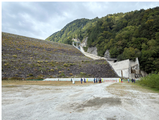
七倉ダム下流の広場
