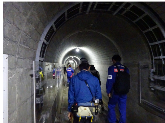
大町ダム（監査廊）
