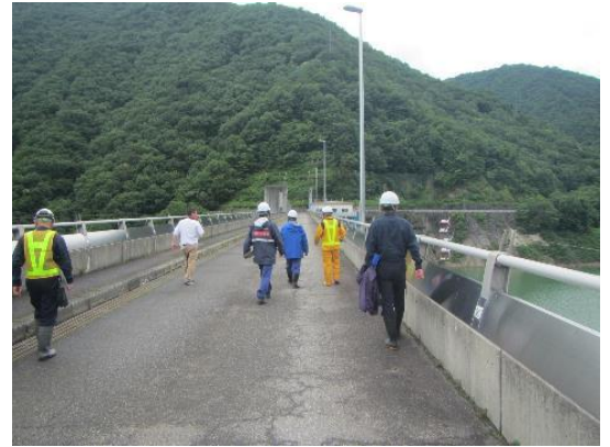
③大町ダム(天端)
