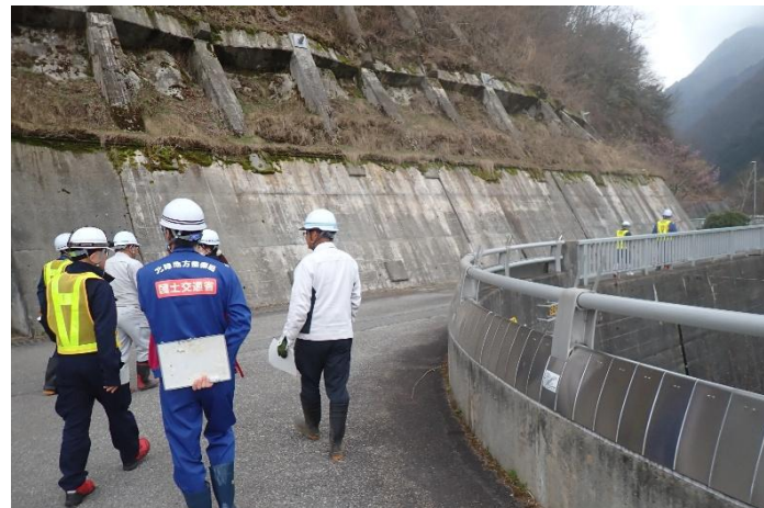
大町ダム周辺施設 点検
