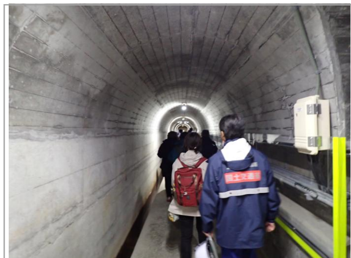
大町ダム（監査廊）
