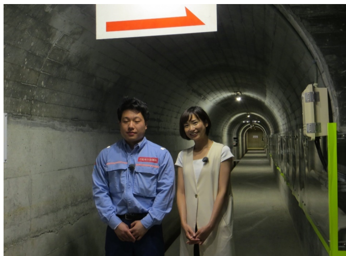
ダム内部の監査廊にて
