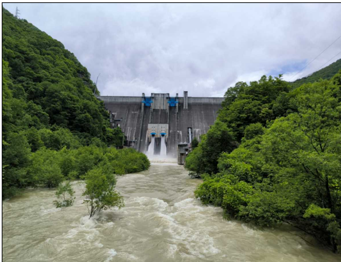
洪水調節中の大町ダム
