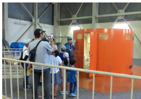
大町発電所内部見学
