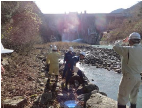
笹平吊り橋下
