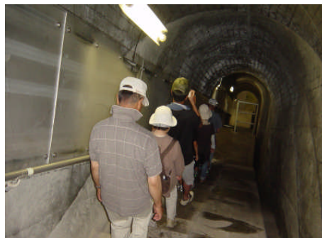
ダム内部見学
