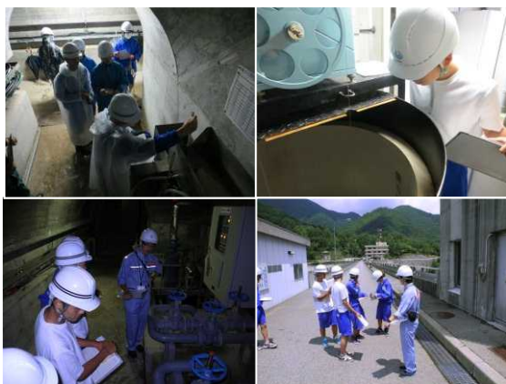
ダムの内部や外観に異常が無いか点検しました。
