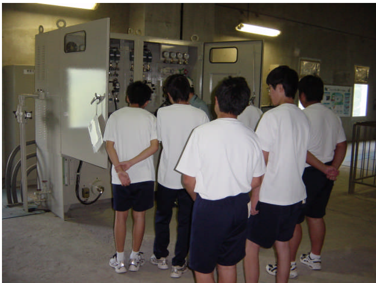
ダムの内部の機械などに異常が無いかが点検しました。
