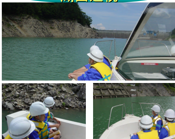
巡視船に乗って、ダム湖の斜面を点検しました。
