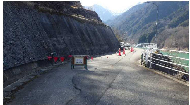
バリケードの設置状況
