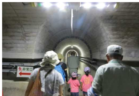
ダム内部見学(堤体内)
