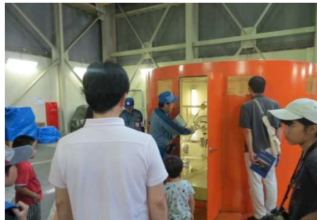
大町発電所内部見学
