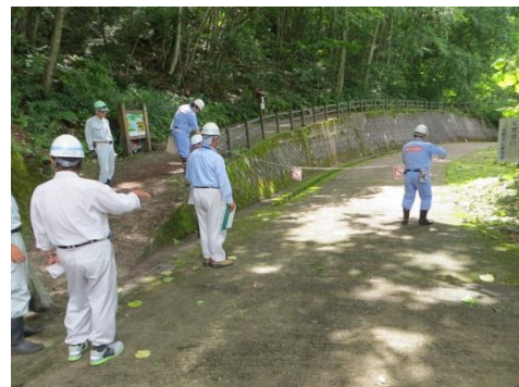
ダム右岸管理用巡視路
