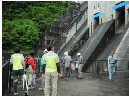
ダム内部見学
