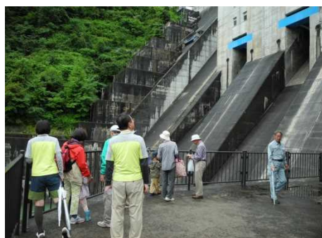
ダム内部見学
