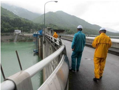
ダムの天端（手摺等に危険が無いかを確認）
