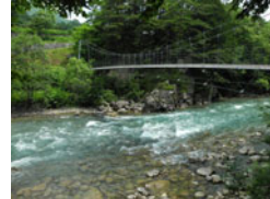
⑲笹平吊り橋と高瀬川
