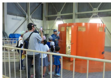
大町発電所内部見学
