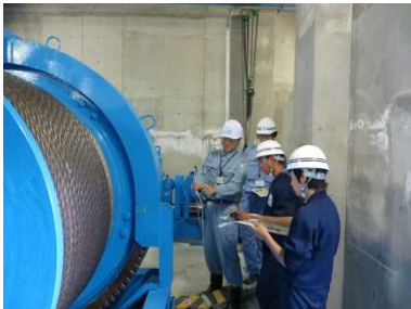
●機械設備の点検
