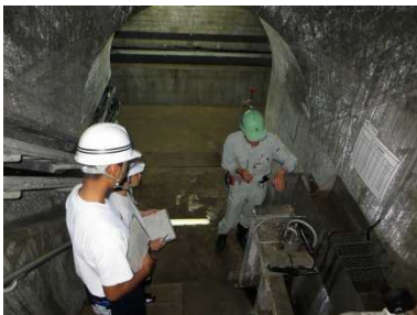
●ダム内部の点検
