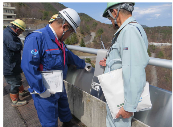
大町ダム上部
