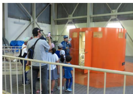
大町発電所内部見学
