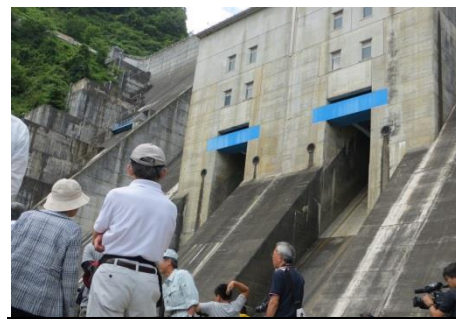
大町ダム内部見学
