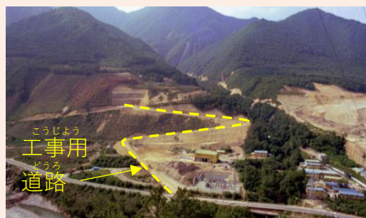
工事用道路をつくった時
