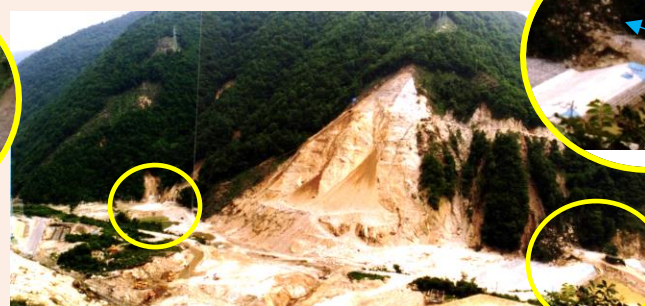
トンネル入口
