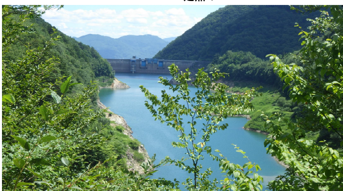
定点5 北葛沢覆道
