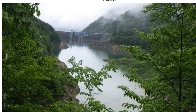
定点5 北葛沢覆道
