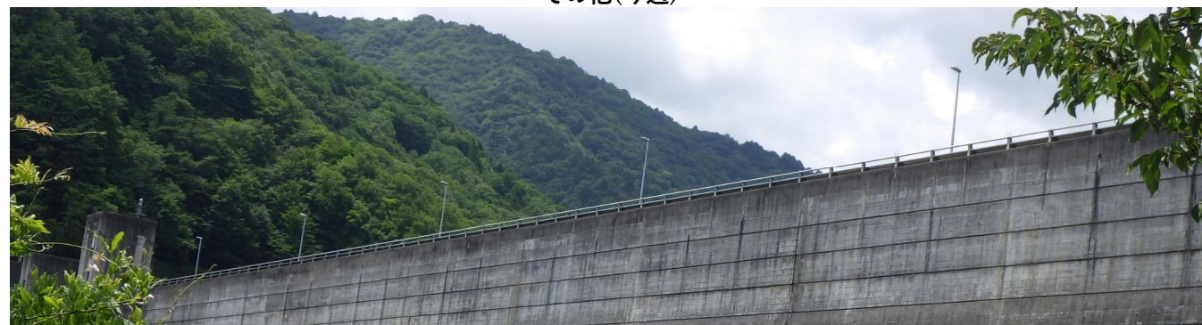
大町ダム(天端)
