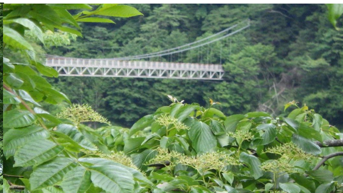
中ノ沢吊り橋
