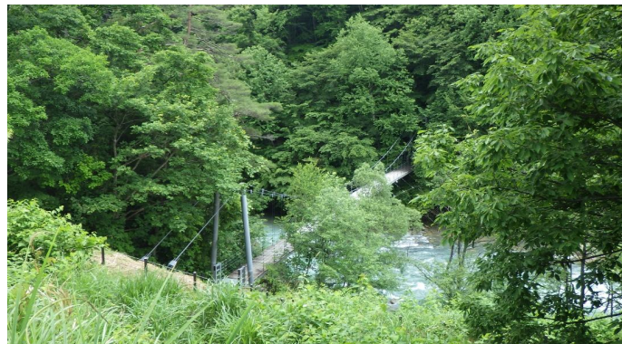
泉小太郎吊り橋
