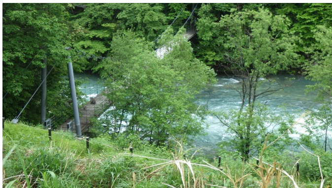
泉小太郎吊り橋
