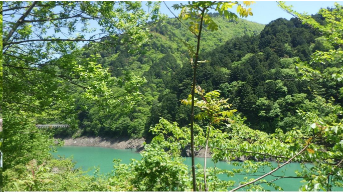
中ノ沢吊り橋
