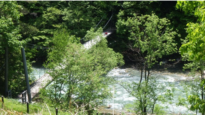
泉小太郎吊り橋
