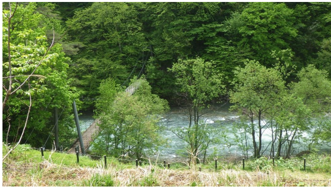
泉小太郎吊り橋
