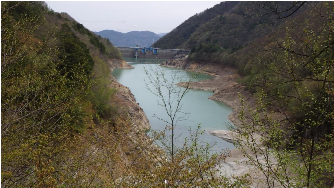
定点5 北葛沢覆道
