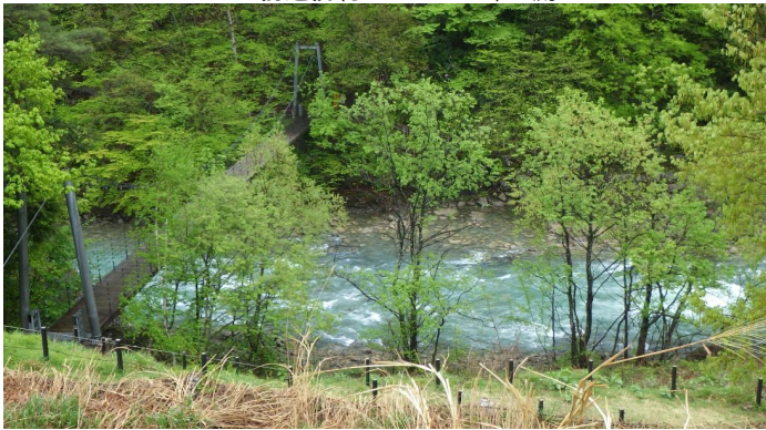
泉小太郎吊り橋
