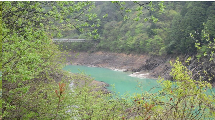
中ノ沢吊り橋
