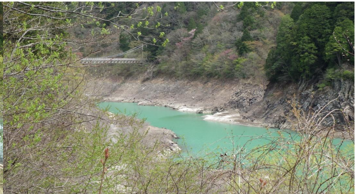
中ノ沢吊り橋
