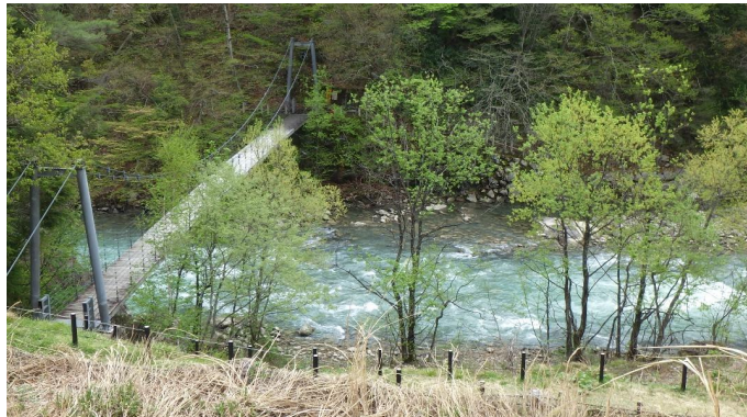
泉小太郎吊り橋
