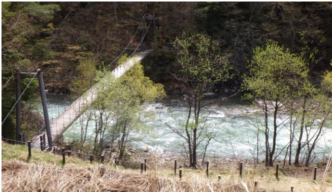
泉小太郎吊り橋
