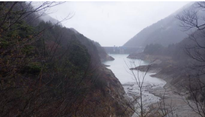
定点5 北葛沢覆道
