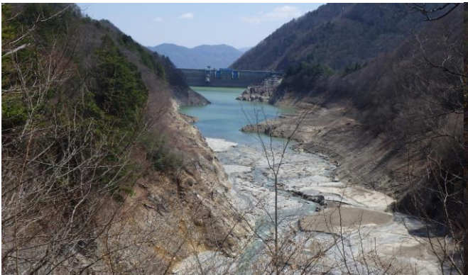
定点5 北葛沢覆道
