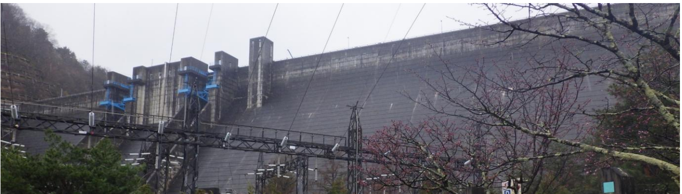
下流公園から大町ダム
