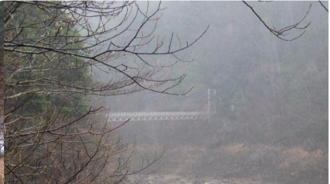
中ノ沢吊り橋
