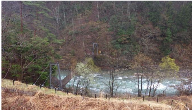
泉小太郎吊り橋
