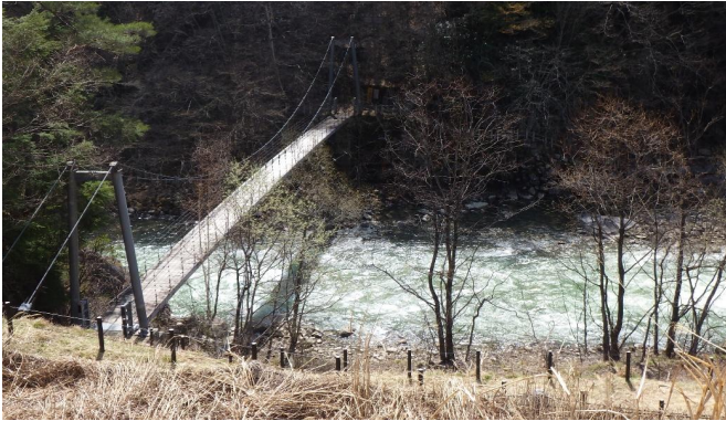
泉小太郎吊り橋
