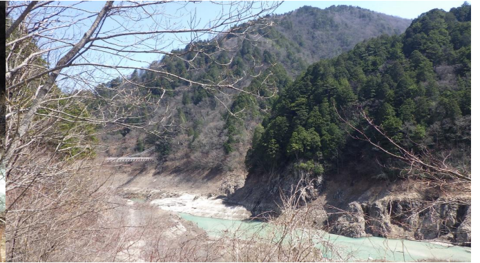
中ノ沢吊り橋
