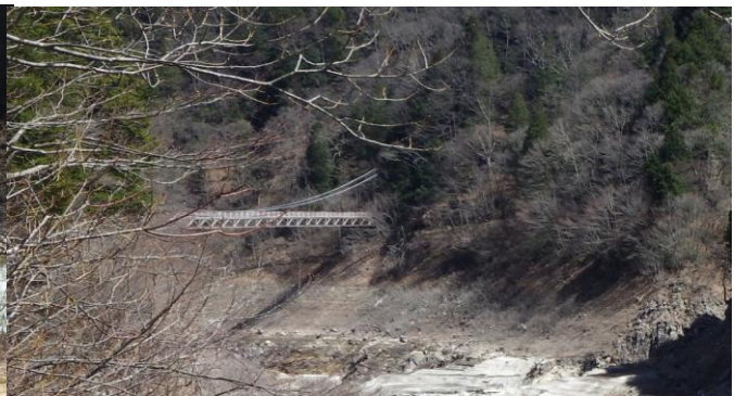
中ノ沢吊り橋
