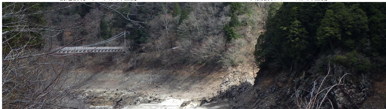
中ノ沢吊り橋
