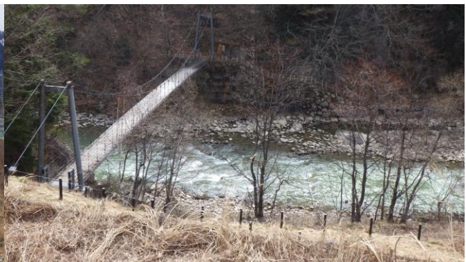
泉小太郎吊り橋
