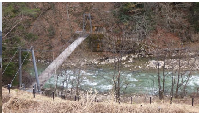
泉小太郎吊り橋
