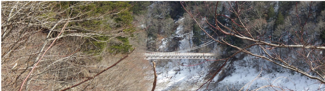
中ノ沢吊り橋
