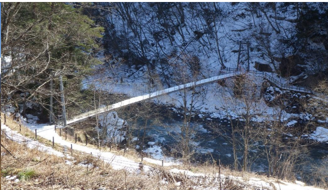
泉小太郎吊り橋
