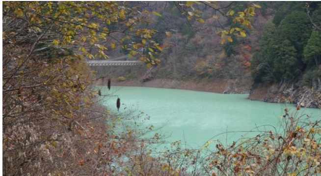
中ノ沢吊り橋
