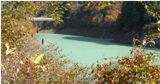
中ノ沢吊り橋
