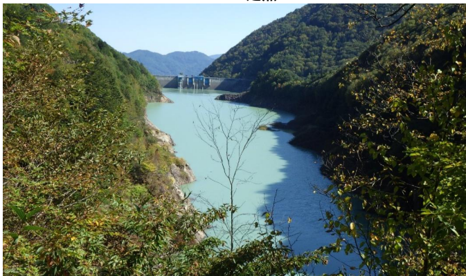
定点5 北葛沢覆道
