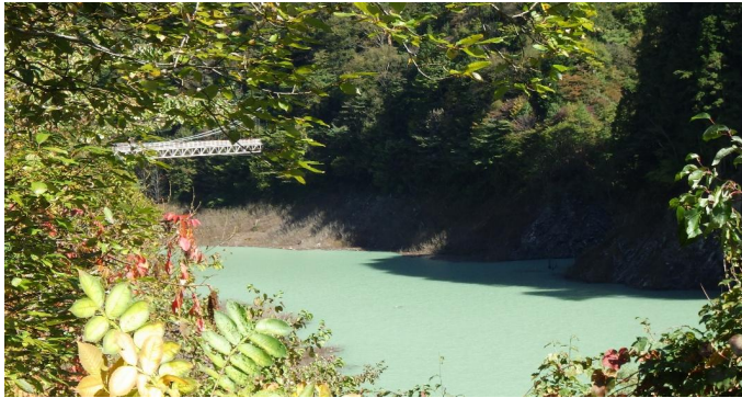
中ノ沢吊り橋
