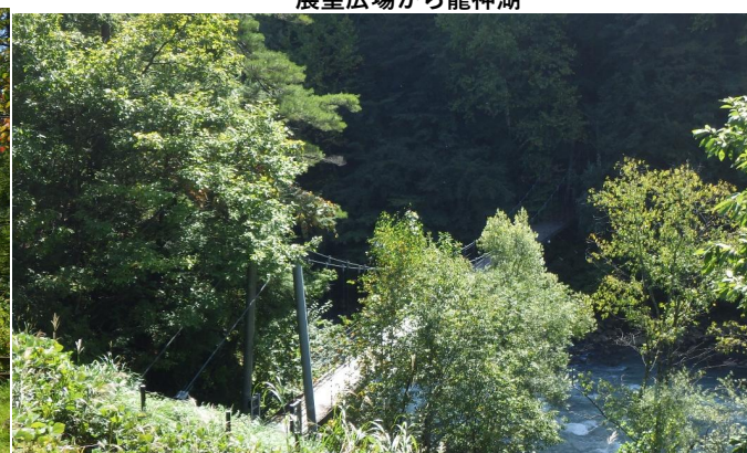
泉小太郎吊り橋
