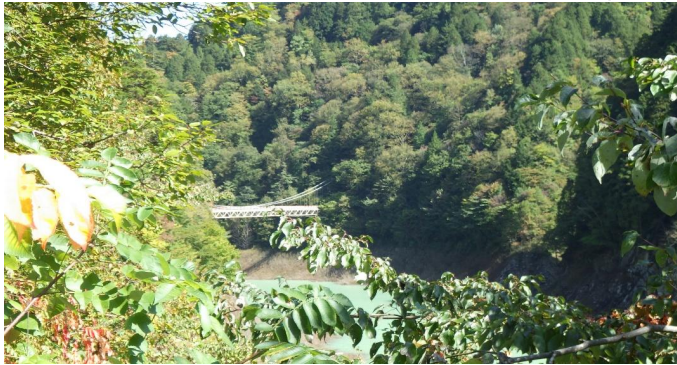
中ノ沢吊り橋①
